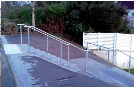
Escalier d'accès au tramway, rue Despiau
