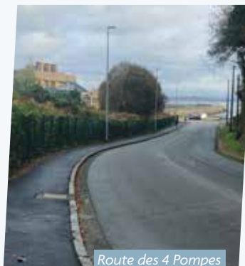
Route des 4 Pompes
