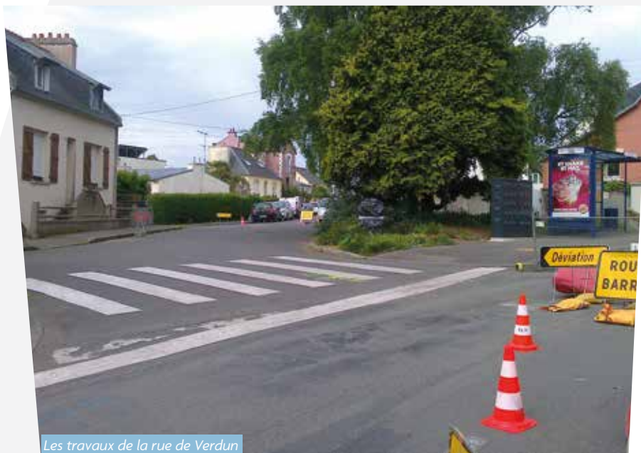
Les travaux de la rue de Verdun
