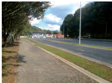
Nouvel aménagement porte de l'arrière garde
