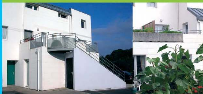
« Lambézellec : chaque appartement dispose d'un accès indépendant et d'un espace extérieur privatif, soit un jardin au rez-de-chaussée, soit une terrasse importante à l'étage. (Brest métropole habitat - Architecte A. Gourvès)
