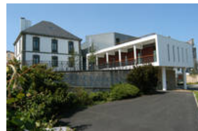
Pôle multiservices de Saint-Pierre Rue Victor Eusen
