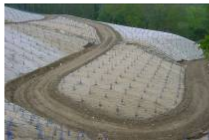
Décharge du Kreisker réhabilitée
